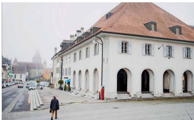
Le bâtiment conservera son enveloppe historique, mais l'intérieur bénéficiera d'une importante rénovation. ARCH. C. JAMBERT
